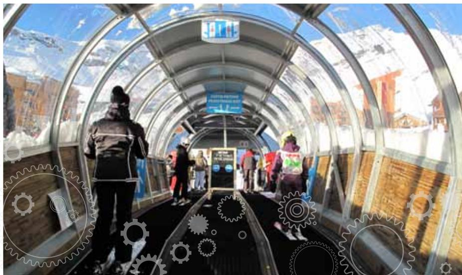
En 2009, Ficap a installé un tapis roulant qui peut transporter 4 000 skieurs par heure, à Val Thorens.
